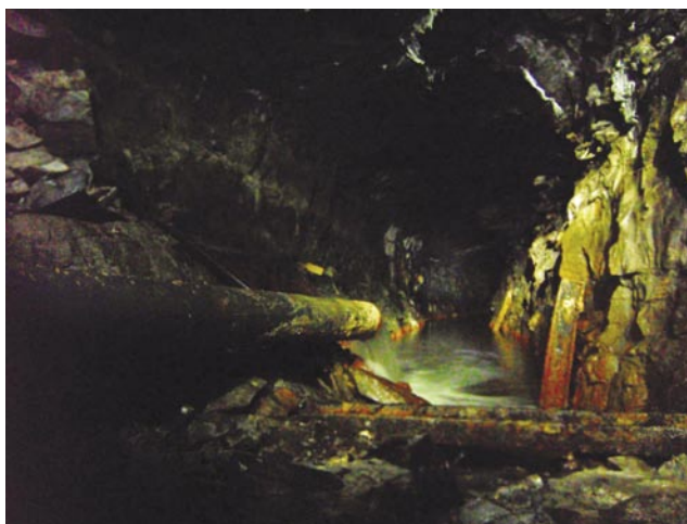
Drenažni tunel za jamsko vodo v Wettelrodeju (Foto: Michael Schumann)
